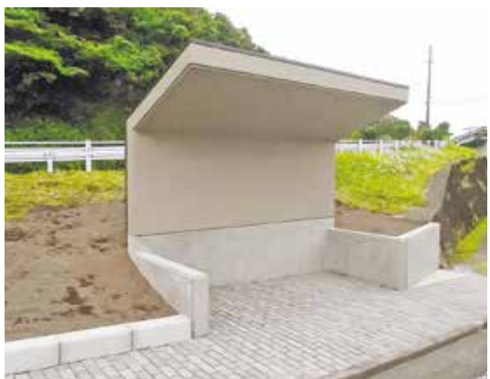
山側に壁を設置したシェルター(阿古・鉄砲場)
