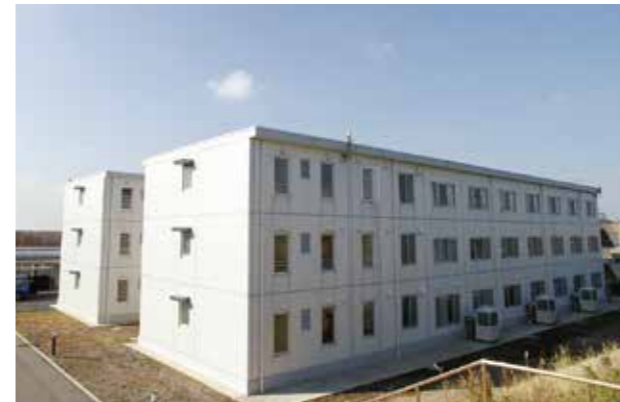
三宅村活動火山対策避難施設（伊豆避難施設）
