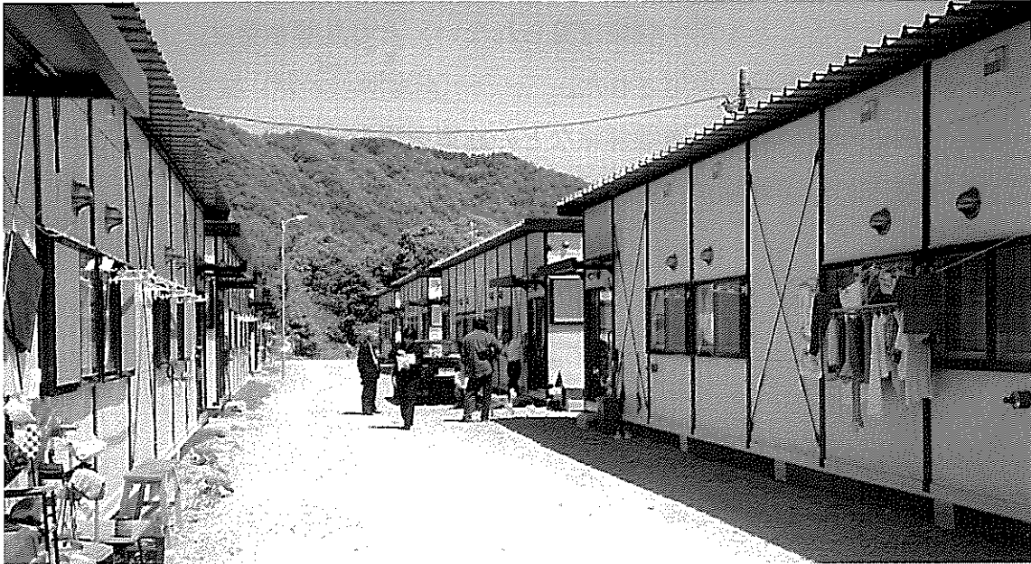
立ち並ぶ「仮設住宅」には、まだ多くの被災者の方々が生活をしている
