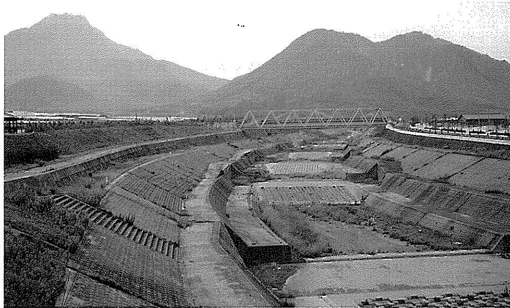
ガマダス計画の実行プラン、地域の安全を守る防災対策事業の一つで完成した水無川拡幅、堤防嵩上、河床掘削、橋掛け事業
