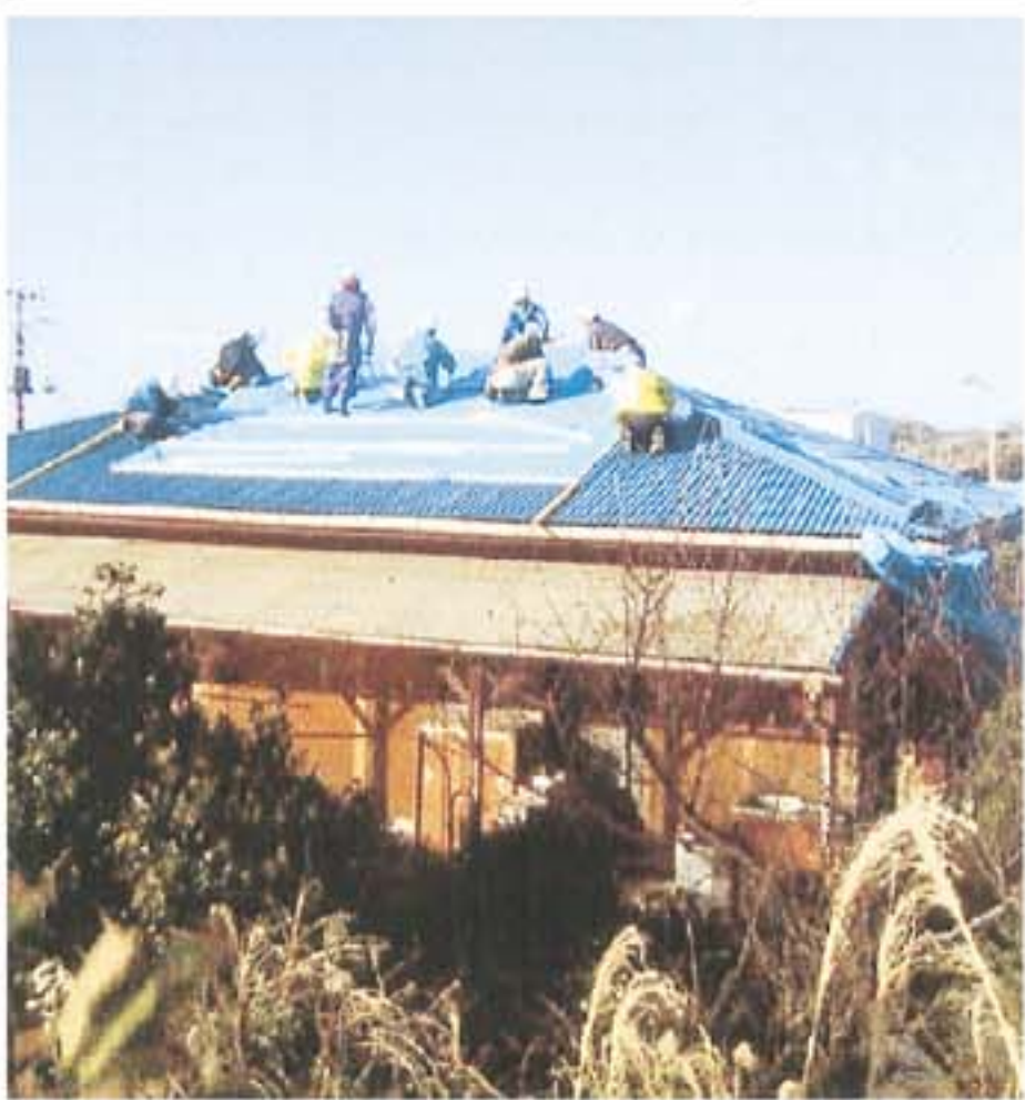
職工組合による雨漏り対策作業
