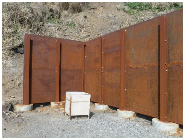
設置した防護壁
