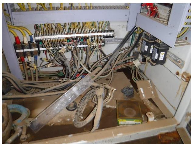
水没したポンプ小屋の制御盤
