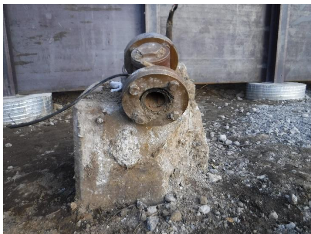
破損した配管
