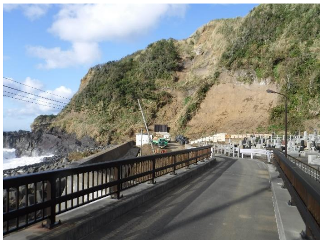
源泉設備周辺
