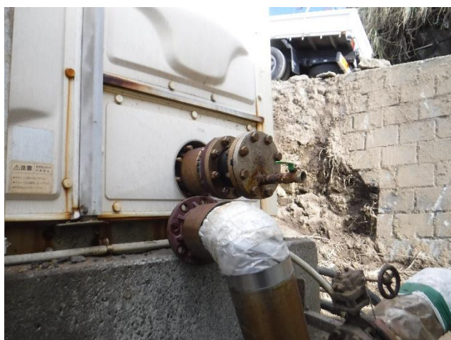
破損した貯湯タンクの配管
