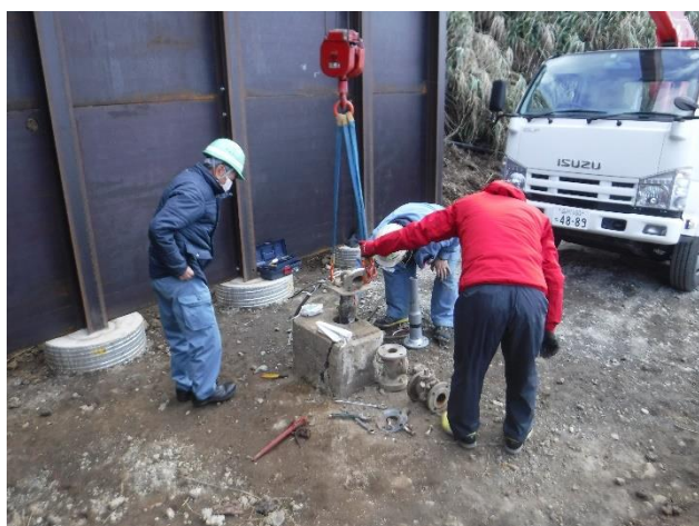
被災設備等の調査
