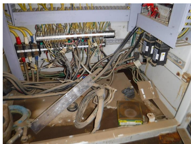
ポンプ小屋の制御盤点検
