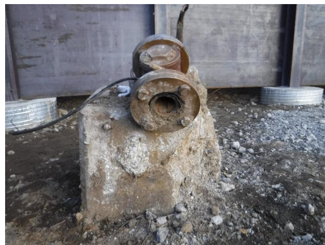
破損した配管
