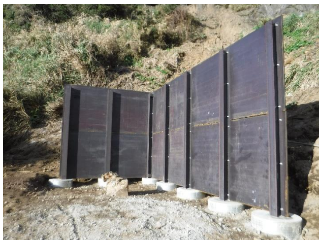
設置した防護壁
