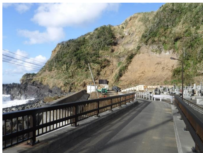
源泉設備周辺
