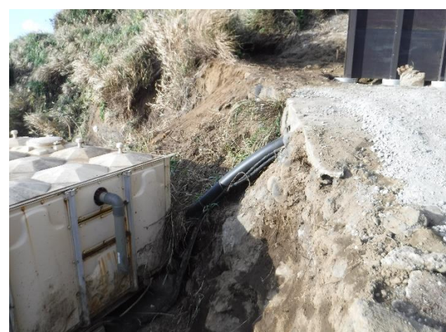
貯湯タンク周辺
