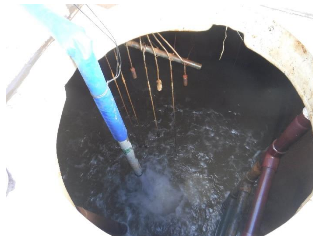
貯湯タンクの漏水調査
